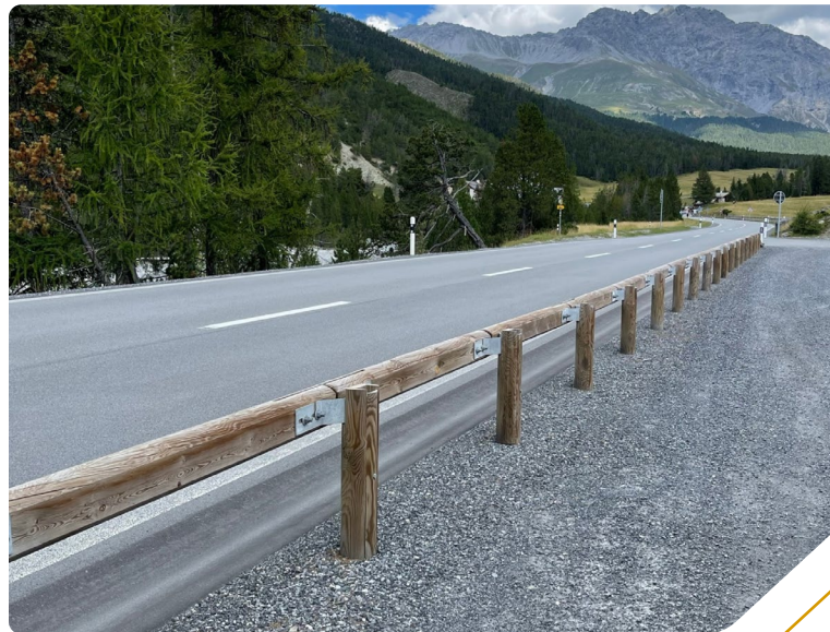
Route départementale de montagne
