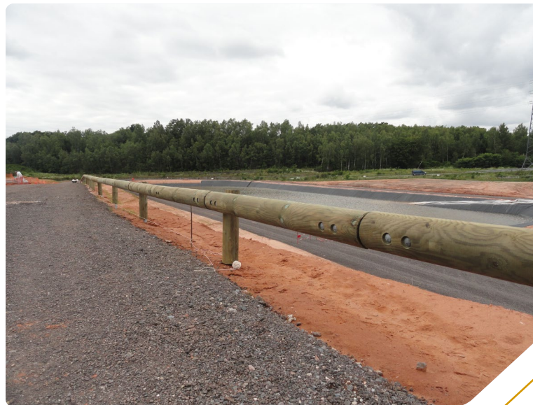
Aménagement de friches industrielles en zone tertiaire
